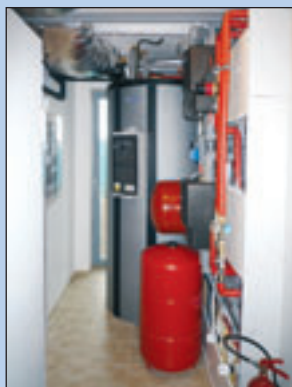
Integrovaný zásobník tepla v technické místnosti
